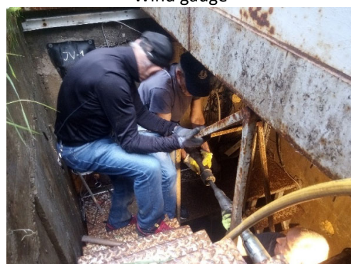
Lysimeter - montage
